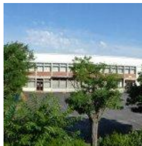
Vue des bâtiments
